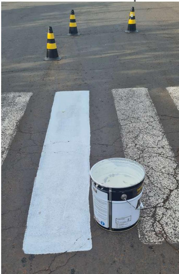
*Figura 5: Aplicação da tinta branca finalizada*
