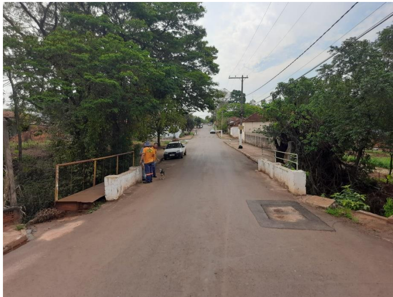
Foto 01 – Vista da ponte com passarela improvisada instalada em 2002.
