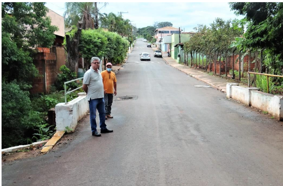
Foto 02 – Vistoria na ponte
