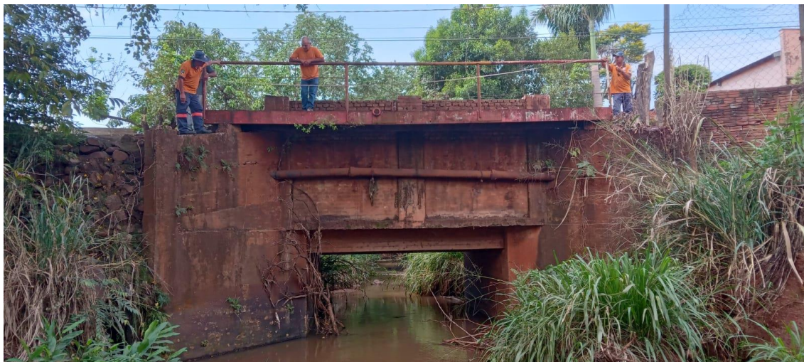
Foto 04 – Vista da ponte já existente
